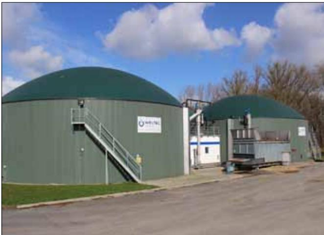
*Den beiden 2.625 Kubikmeter messenden Edelstahl-Fermentern ist für die optimale Bevorratung eine unterirdische Grube als Vorlager vorgeschaltet.*
