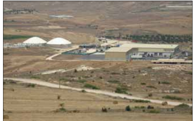
Auch Zypern setzt auf Biogas-Know-how „Made in Niedersachsen“. Die WELTEC-Biogasanlage verarbeitet die Abfälle eines Schlachthofes.
