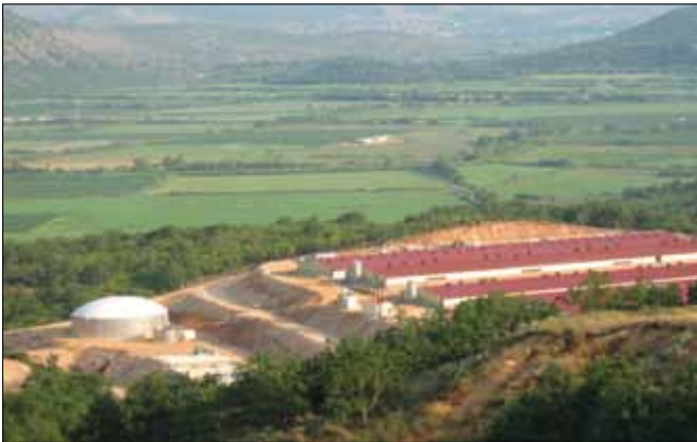
Griechenland: Die landwirtschaftliche Edelstahl-Biogasanlage für einen Schweinemäster ist eine von sieben Anlagen, die WELTEC BIOPOWER bislang in Griechenland gebaut hat.
